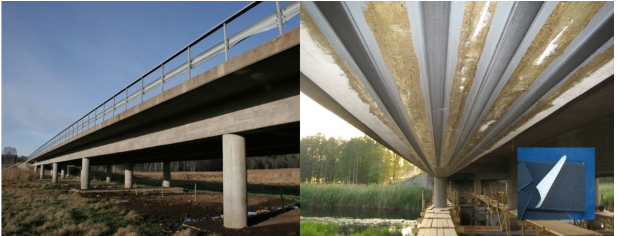
Figur 24 Passiv förstärkning med kolfiberlaminat, (Foto B. Täljsten)
