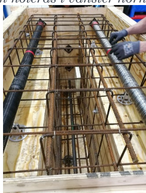
Montering av armeringskorg samt foderrör
