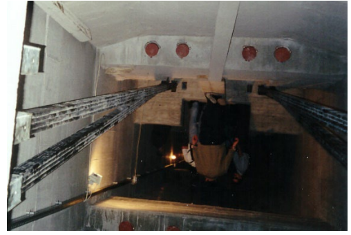
Figur 21 Extern efterspänning applicerad på broar med lådbalkar av betong Foton från en fransk bro på höghastighetslinjen till Marseille till vänster och en ungersk bro på den nya godslinjen genom Slovenien till Medelhavet (Foton av B. Paulsson)
