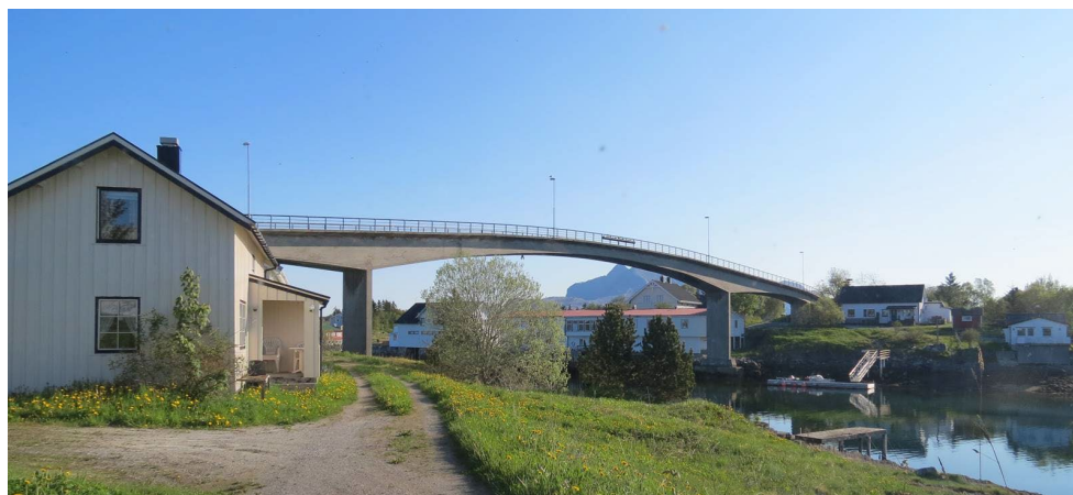
Figur 64 Foto av Herøysundsbron, foto B. Täljsten
