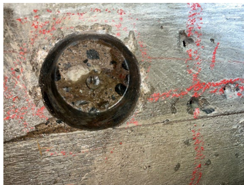
Borrning in till ca 10-15 mm från foderrör
