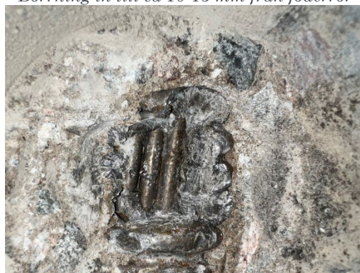
Inspektion av frilagda spännkablar
