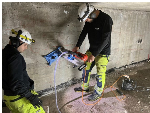
Montering av kärnborrhingsutrustning
