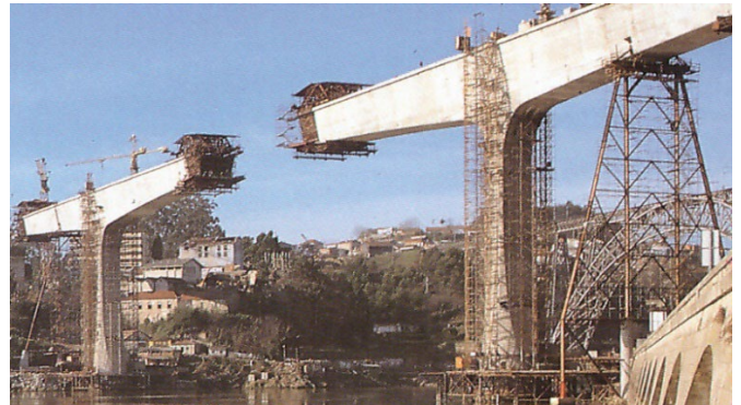
Figur 22 Bilder från den nya järnvägsbron i Porto visar förberedelser för extra extern efterspänning, (Nova ponte ferroviaria sobre o Rio Douro no Porto) (Foton av B. Paulsson)
