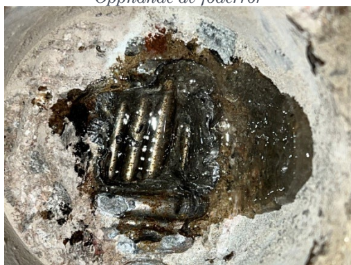
Tätning/lagning med epoxi
