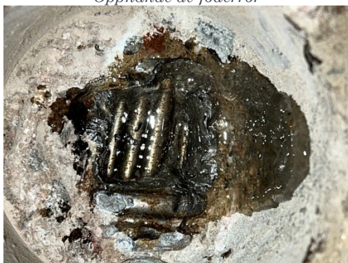
Tätning/lagning med epoxi
