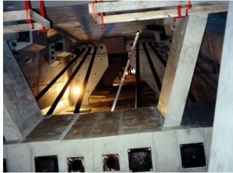
Figur 21 Extern efterspänning applicerad på broar med lådbalkar av betong Foton från en fransk bro på höghastighetslinjen till Marseille till vänster och en ungersk bro på den nya godslinjen genom Slovenien till Medelhavet (Foton av B. Paulsson)
