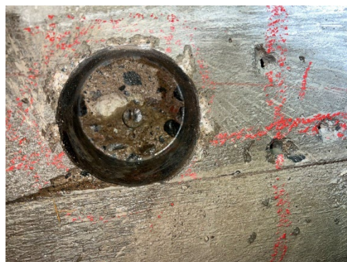
Borrning in till ca 10-15 mm från foderrör
