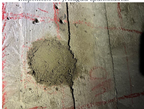
Igengjutning med betong
