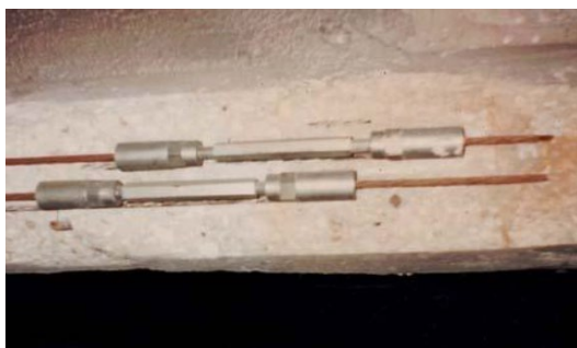
Figur 23 Skarvning av spännlinor, (Harris m.fl., 2009)
