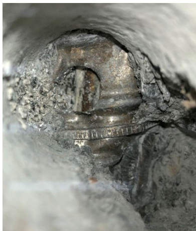
Foderrör 1SC – verifierad injektering
