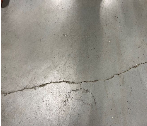
Figur 6 Krympsprickor i industrigolv, foto B. Täljsten
