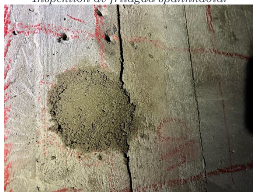
Igengjutning med betong
