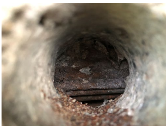
Figur 85 Hålrum i foderrör 1NC
