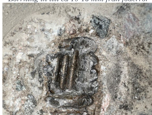
Inspektion av frilagda spännkablar
