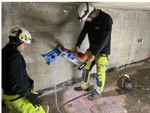
Montering av kärnborrningsutrustning
