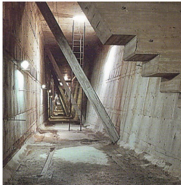
Figur 22 Bilder från den nya järnvägsbron i Porto visar förberedelser för extra extern efterspänning, (Nova ponte ferroviaria sobre o Rio Douro no Porto) (Foton av B. Paulsson)
